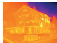
Wärmebild ohne testo ScaleAssist
